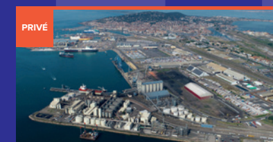
MODERNISATION DU SITE INDUSTRIEL Investissement Privé SAIPOL pour 28M€
