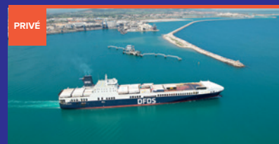
POSTE PÉTROLIER PIPELINE ET CUVES Investissement Privé BP pour 130M€
