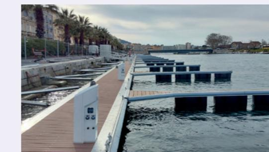
**Quai Vauban** : L'objectif était la création de **57 places** destinées à des navires de catégories 3 et 5 de gabarit supérieur à l'existant. Les infrastructures mises en place sont équivalentes à celles réalisées sur le quai Maillol, avec des pontons fixés sur bracons, avec accès sécurisés, et bornes d'alimentation en eau et en électricité. Les travaux ont été finalisés en février 2025, pour un montant total de **665 K€**.
