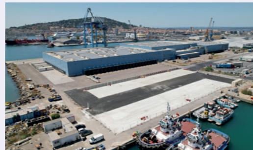
La réalisation du **nouveau parc REEFER**, comprenant une nouvelle alimentation électrique HT et la remise en conformité des équipements du poste (transformateur, cellules, comptage, etc.), permet désormais d'alimenter **252 prises Reefer** sur un terre-plein en chaussée lourde de **6 000 m<sup>2</sup>**. Les travaux ont démarré fin 2024 et ont été livrés à l'été 2025 afin de brancher les premiers conteneurs frigorifiques de la ligne MSC. Montant de l'opération : **1,6 M€**.
