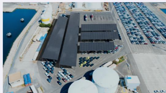
Lancement des travaux pour la mise en place de **8 000 m<sup>2</sup> d'ombrières photovoltaïques en autoconsommation** sur l'arrière-quai G, avec une puissance de 1,5 MWc. L'objectif est de répondre à l'augmentation des puissances demandées pour les branchements électriques à quai, décarboner le port à travers l'apport d'énergie renouvelable et permettre une autonomie sur la fourniture de notre énergie. Un investissement de **2,3 M€** est prévu pour une mise en service en juin 2026.
